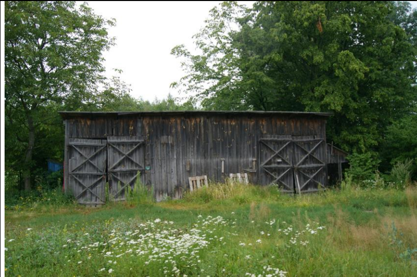
Widok od strony południowej
