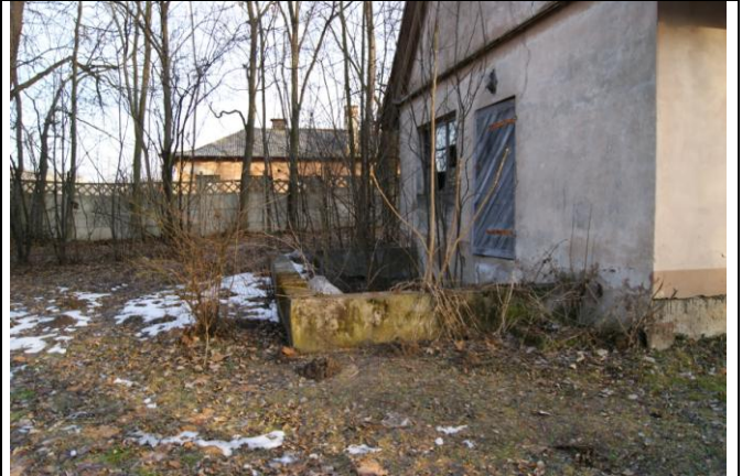
Stan fundamentów i silosa na kiszonkę
