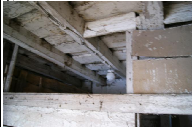
Stan belek stropowych
