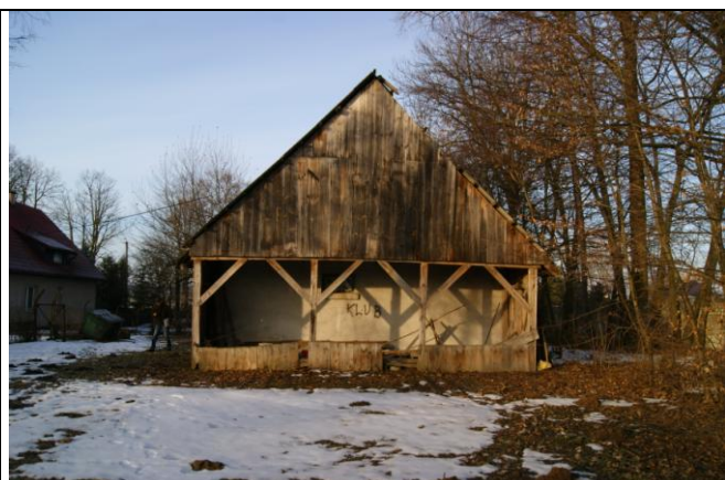
Elewacja wschodnia- pozostałości stodoły
