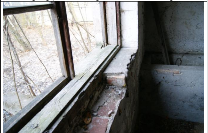
Uszkodzenia stolarki okiennej
