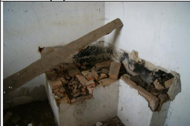
Uszkodzenia paleniska
